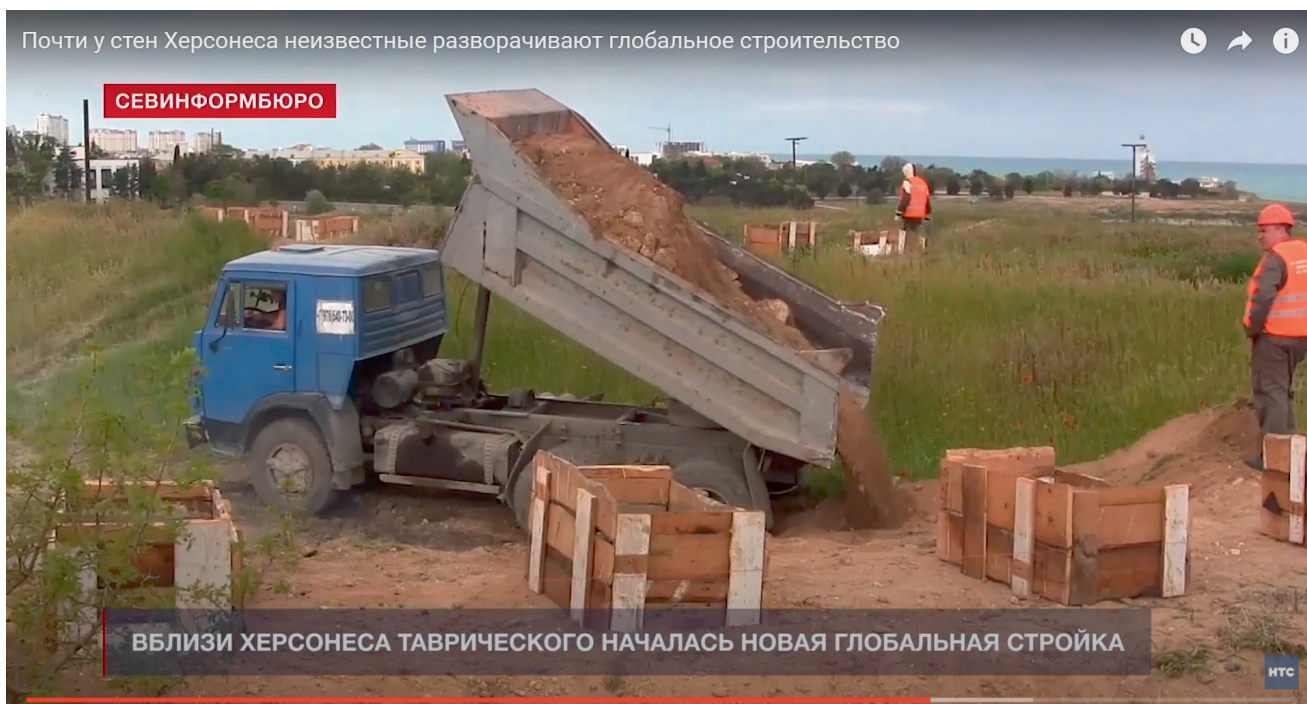
Фрагмент відео № 3 — Використання важкої техніки задля проведення робіт на території Херсонеса Таврійського, за допомогою якої переміщується ґрунт, що містить культурний шар.
